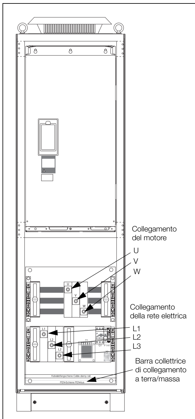
Fig. 56 Collegare i cavi del motore e della rete elettrica ai morsetti e quelli di terra/massa alla barra collettiva.
