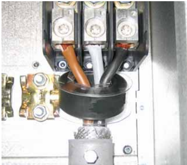
Abb. 55 An den Motorkabeln montierter Ferrit-Kern
