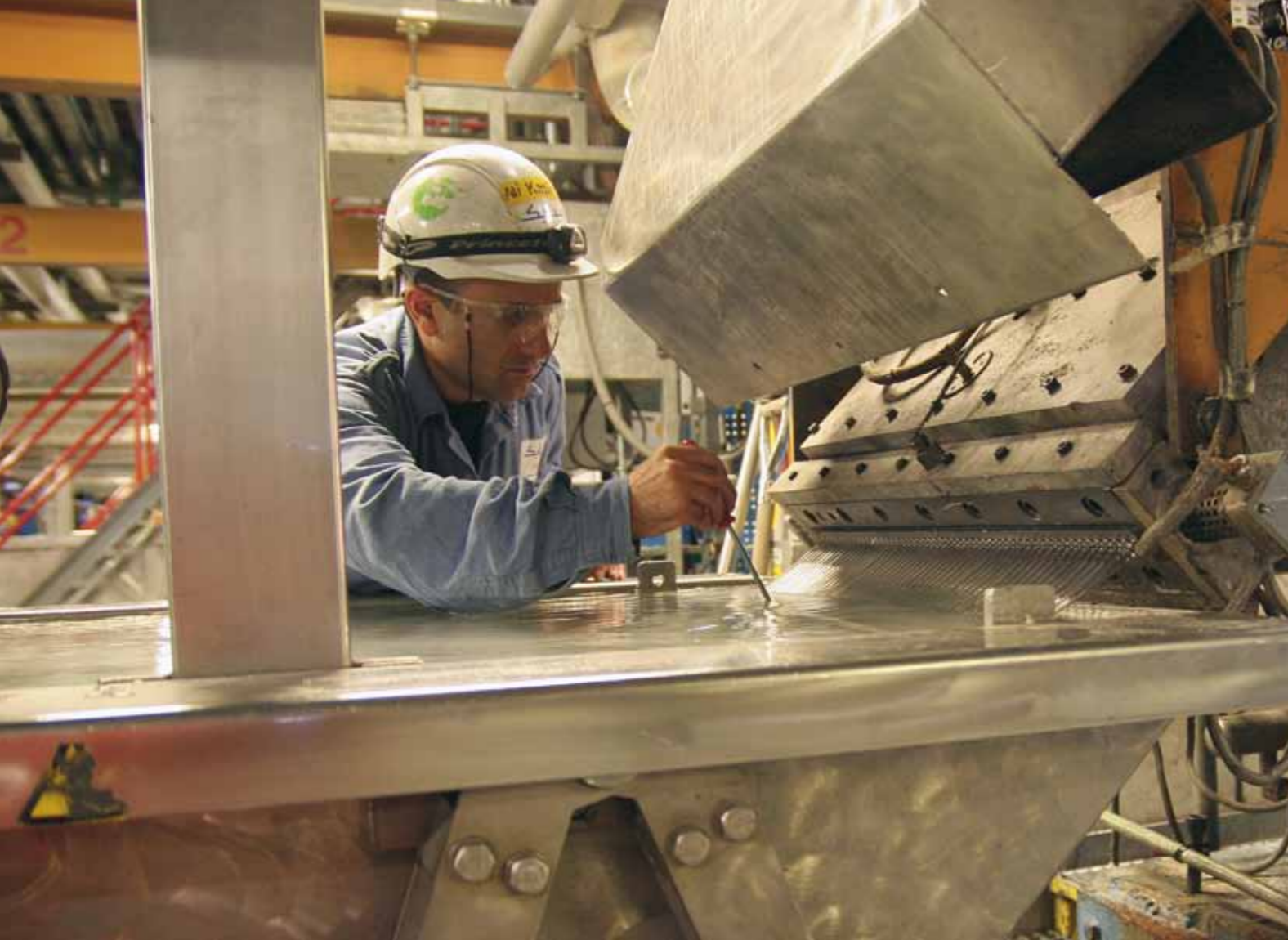
Alla elmotordrivna tillämpningar i blandningsprocessen styrs med Emotron frekvensomriktare. Närmare 250 enheter styr allt från pumpar på 370 W till strängsprutmaskiner på 800 kW.
